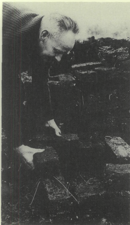
Afb. 23. waterman in aanbouw
